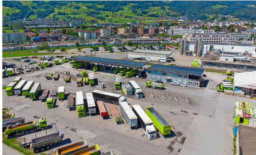
PV-Anlage auf dem Dach und eine topmoderne Ladeinfrastruktur für E-Lastwagen: Ein Blick auf das Langgraben-Areal von Käppeli Logistik in Sargans.
